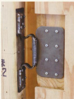
株式会社サトウ(東京都国立市)は、従来タイプに改良を加えた新タイプのΩシステム9000タイプと狭小間口タイプ600の耐力壁大臣認定を取得。1月27日に狭小住宅の実大振動実験を行った。
