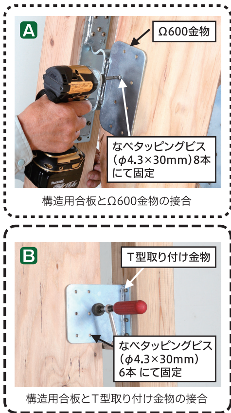
構造用合板(12mm厚)加工2枚 ※JAS規格品で特類2級以上 ※別売り
