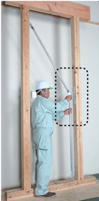
写真3「鋼管筋かいの取付け」
